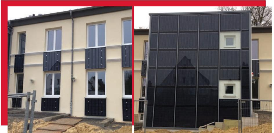
Zwischen den Fenstern der Fassade, am Treppenhaus und auch auf dem flach geneigten Dach montierte Meyer Technik an einem Bürogebäude in der Heriwardstraße in Bremen Solarmodule.
