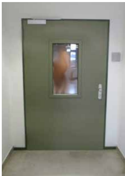
Die Zugangstür muss einbruchssicher sein und gleichzeitig den Blick nach draußen ermöglichen. Dazu wurde eine Speziallösung erarbeitet.
