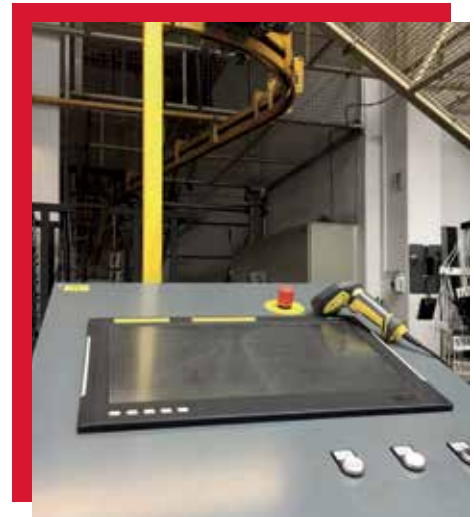
G&M modernisiert Fördersystem bei der Firma OMT.
